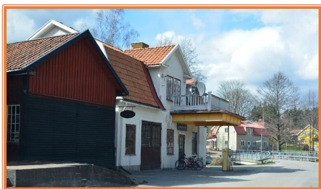
Mörtfors bilverkstad byggdes 1933 och inrymmer idag ett antikvariat.
